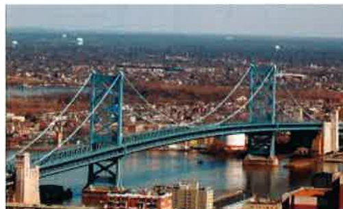
採用現場例：Ben Franklin Bridge
