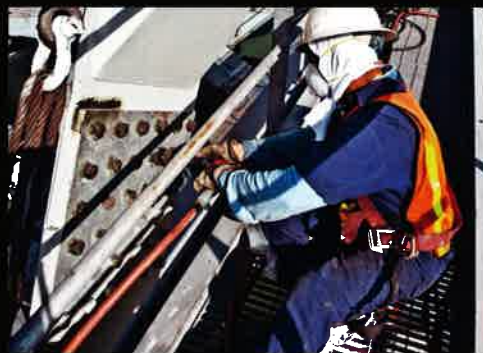
ニードルスケーラー作業
