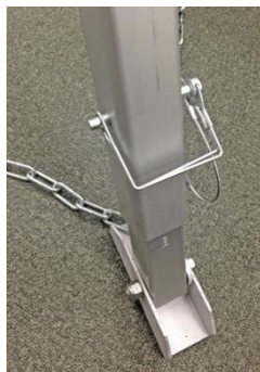
図3 下部ピンとゴム面の設置
