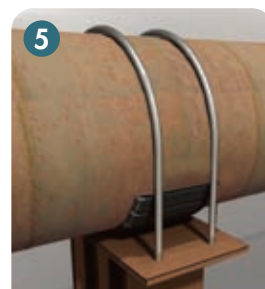
5 配管のサポートへの再取付
