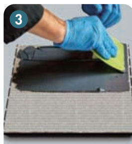
3 パッドへの樹脂塗込み
