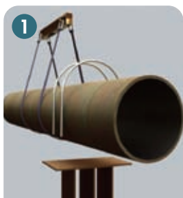
1 配管を持ち上げ1種ケレン
